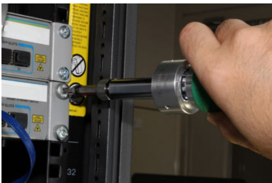
Anwendungsbeispiel Linsenkopfschraube Application example binding head screw
