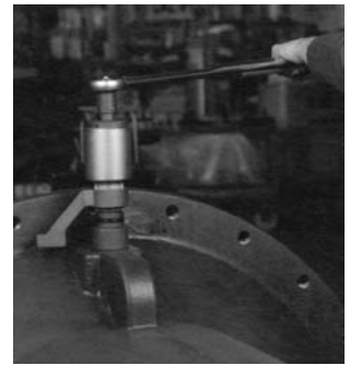
Getriebemontage M 30-10.9 - 2000 Nm
