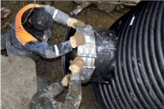
Zugfeste Installation bei einem Revisionsschacht aus Polyethylen.
