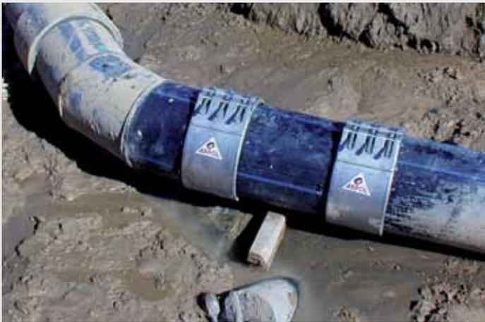
Zugfeste Reparatur mit einem Rohrstück aus Polyethylen.
