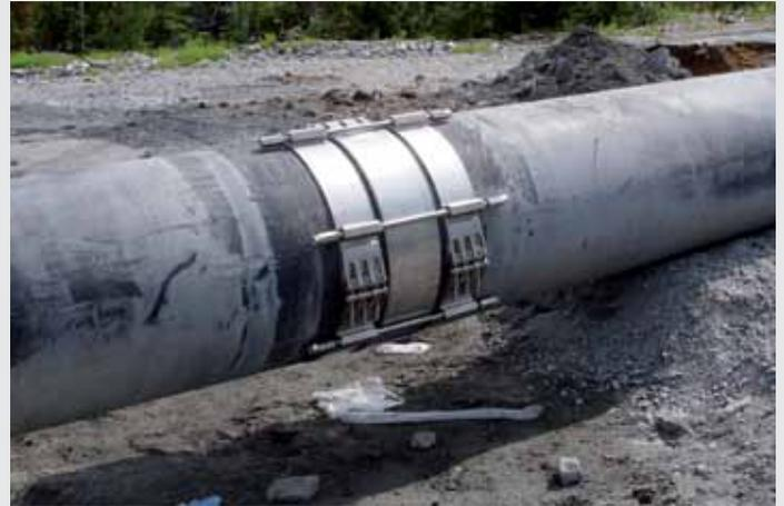
Zugfeste Installation einer PE-Rohrleitung für das Abwasser eines Bergwerks.
