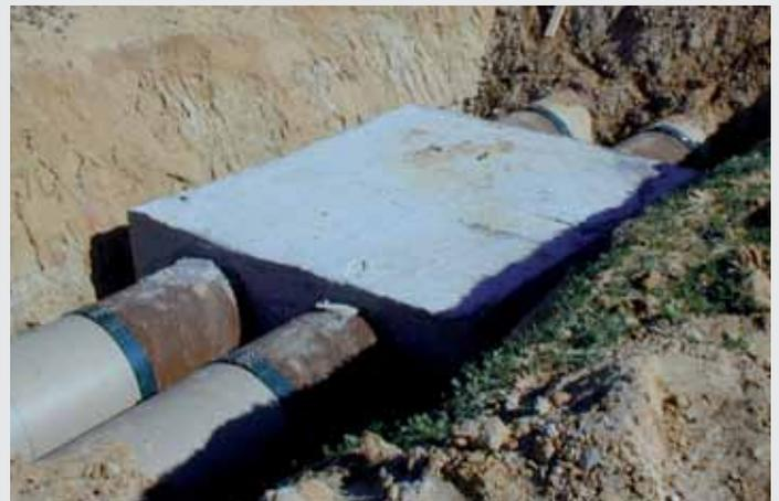
Verbindung von GFK- und Stahlrohr mit unterschiedlichen Aussendurchmessern bei den Zu- und Abläufen einer Verteilkammer.
