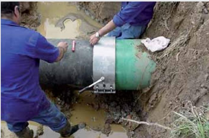
Reparatur einer GFK-Leitung mit einem Rohrstück aus Guss-eisen mit unterschiedlichen Aussendurchmessern.
