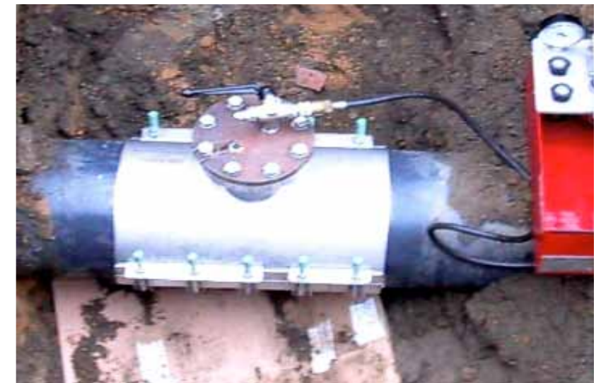
Montaje de una SST de dos piezas con brida a un ducto de PE
